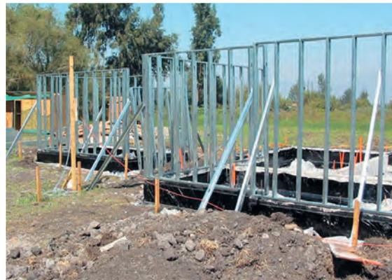
Con el muro en posición se procede a chequear el plomo y *nivel*, una vez en su lugar se arriostra y asegura con diagonales, a lo menos una.
