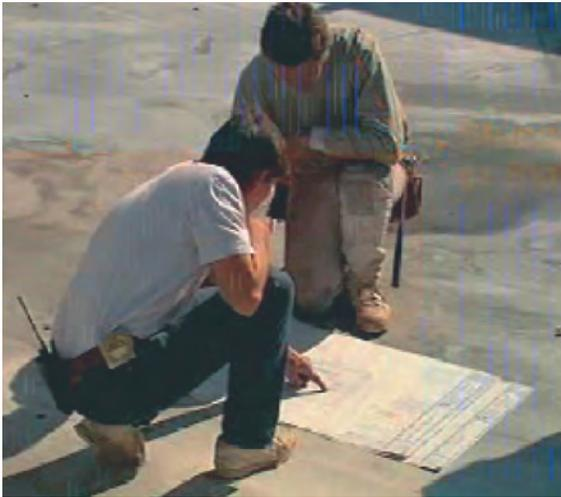
Del trazado realizado a tamaño real se desprenden las medidas exactas de cada uno de los elementos y con ello se puede cortar los pie derechos y soleras de acuerdo al diagrama realizado para cada muro.
