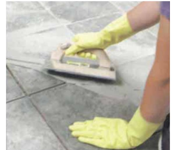
Con un movimiento amplio pasar la llana, inclinada en un ángulo de 45°, a través de las líneas de fragüe para forzarlo a su interior. Se limpia el exceso de fragüe con una esponja húmeda.
