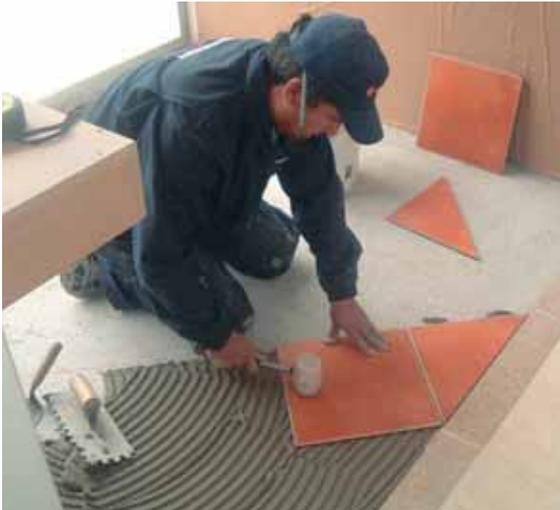
Luego se marcan las palmetas que irán en las orillas para cortarlas. Para considerar el espacio para el *fragüe* se coloca una palmeta verticalmente contra la pared. Después se presenta una palmeta suelta directamente sobre la última palmeta completa. Se coloca otra palmeta a tope contra la palmeta puesta vertical y sobre la primera palmeta suelta que se puso. Se marca sobre esta última la línea que genera la palmeta que está a tope con la vertical.
