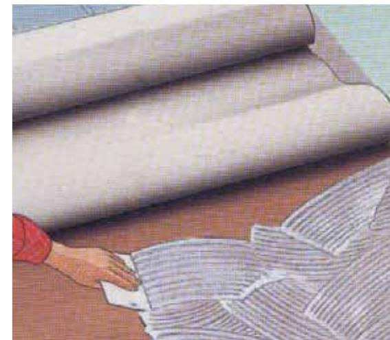
Se deja secar el adhesivo el tiempo indicado por el fabricante. Se alisa el adhesivo para reducir la posibilidad de que se produzcan burbujas de aire.
