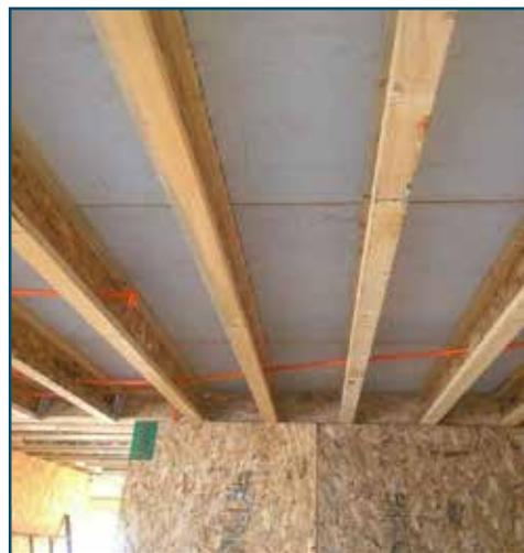
Para la disminución de chirridos es recomendable usar entre el tablero y la viga un sello o usar adhesivos estructurales de poliuretano o híbridos del tipo AFG -01 o ASTM-D3498, los que además ayudan a un mejor desempeño de la estructura.
